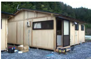
<地元業者が施行した仮設住宅>
