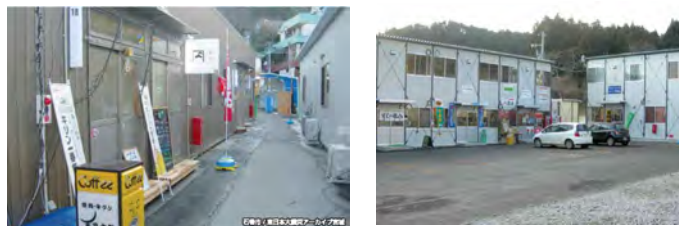
<市と商工会議所が設置した仮設商店街>
